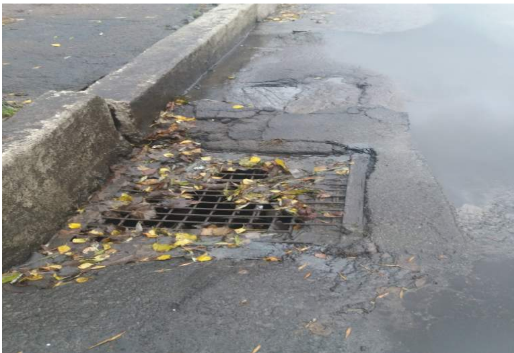
Рисунок 4.24 – Ливнева каналізація по вул. Набережна
