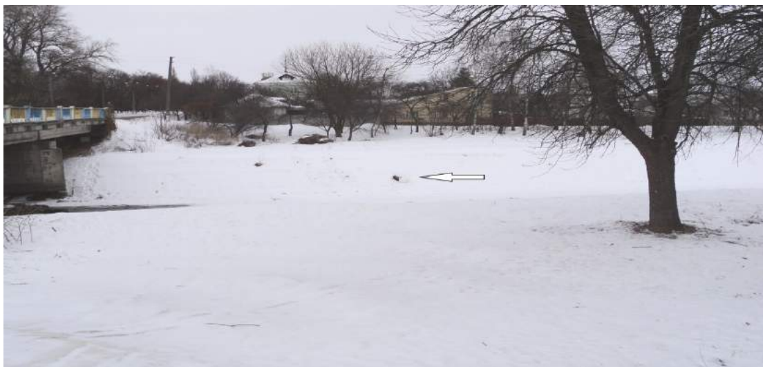
Рисунок 4.7 – Водовипуск ПК 1243+40 пр. берег
