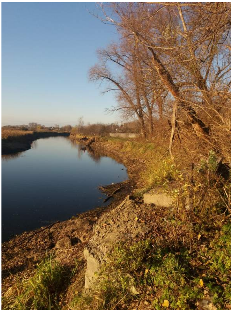
Рисунок 5.24 – Старі будівельні конструкції на узбережжі.
