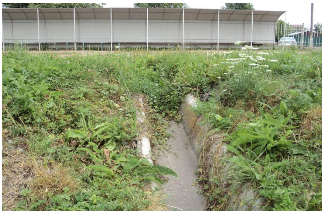
Рисунок 4.10 – Водовипуск ПК 1248+30 лів. берег (базарний міст) влітку
