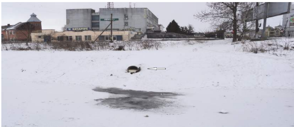
Рисунок 4.10 – Водовипуск ПК 1248+30 лів. берег (базарний міст)
