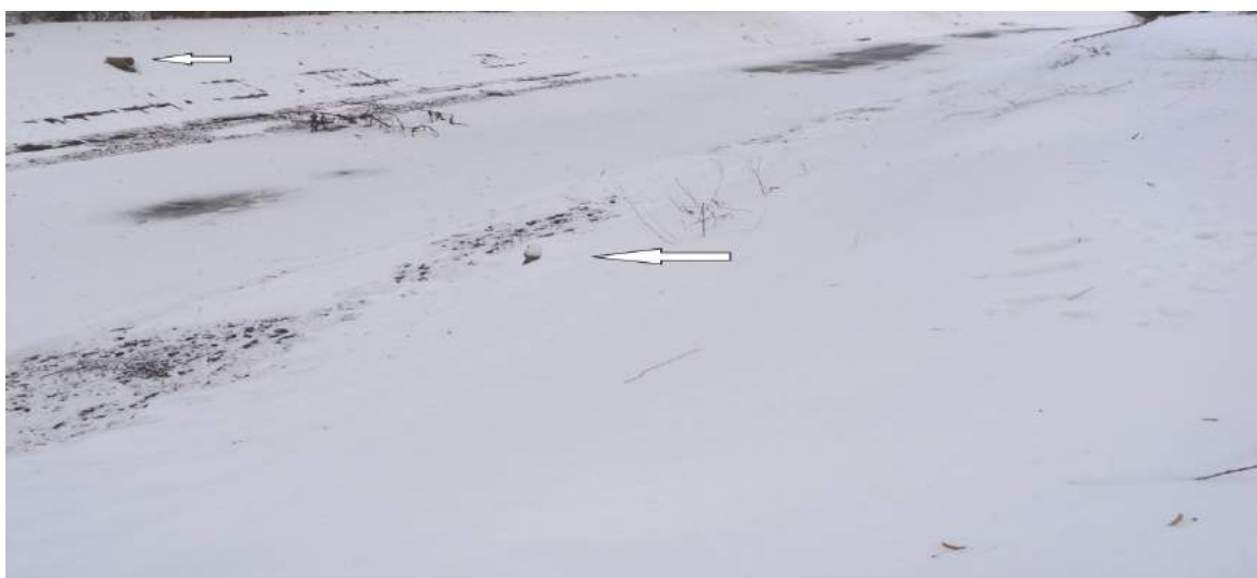
Рисунок 4.17 – Водовипуск ПК 1241, ПК 1240
