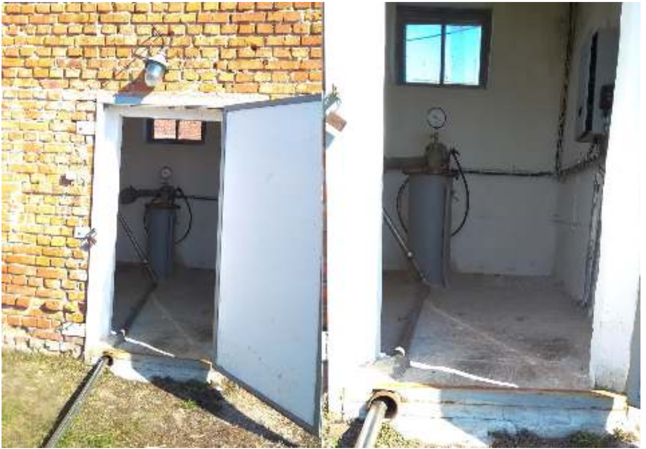
Рис. 4 – Насосна станція та обладнання свердловини № 1
