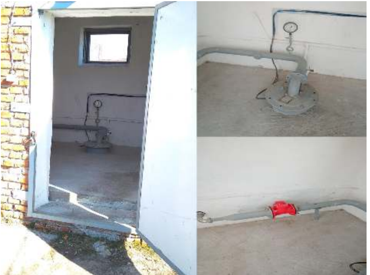
Рис. 5 – Насосна станція та обладнання свердловини № 2
