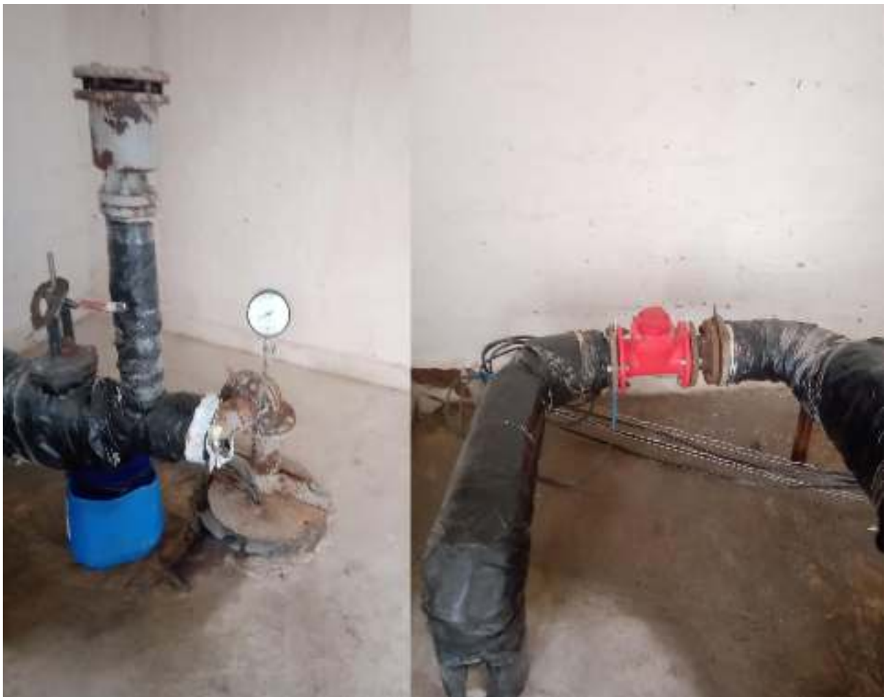
Рис. 6 – Насосна станція та обладнання свердловини № 3
